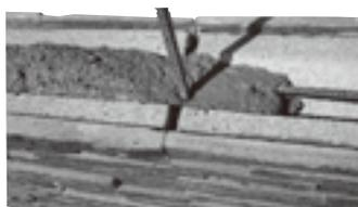
横筋空洞部へのモルタル充填
