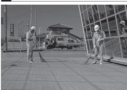
乾燥した細目の砂をホウキなどで目地に落とし込み、作業は完了です。
