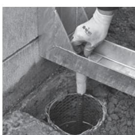
5. ロックボルトのセットとコンクリート流し込み
