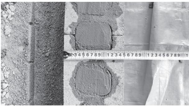
●ステッププラス平板とその接着面を確保する為、コンクリートブロックにモルタルを充填します。
