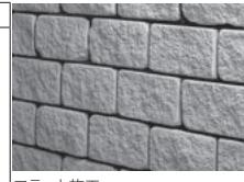
基本横筋兼用型の化粧面を一定方向にし施工を行ってください。製品の中心がズレるため、縦筋の設置、基礎の立上り幅には注意してください。
