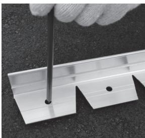
①端部より固定、アンカーは30cm間隔で打ち込む
