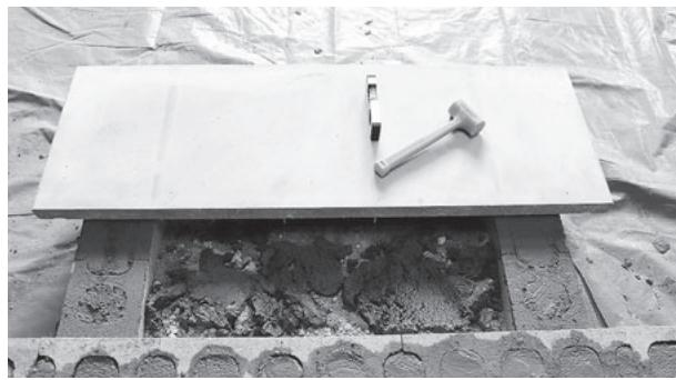
●ステップ内側に下地碎石を敷きます。アンカーボルト周りは捨てコンで固めるので碎石は充填はしません。
