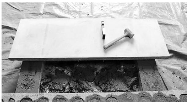
●ステップ内側に下地碎石を敷きます。アンカーボルト周囲は捨てコンで固めるので碎石は充填はしません。
