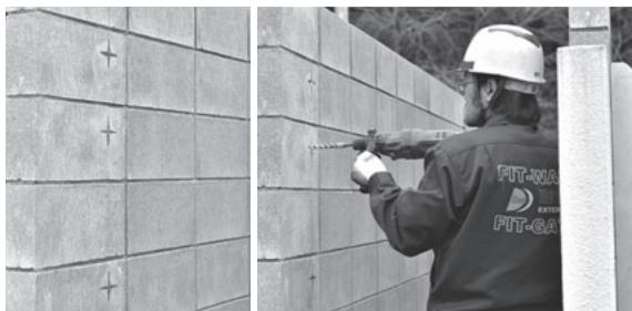
3. 取り付けボルトの位置出しと穴加工
