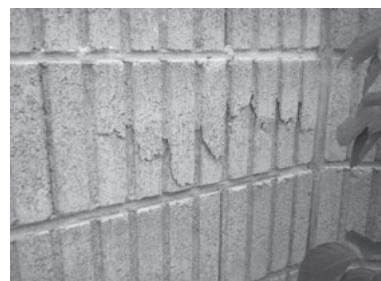
空洞部に水が滞留して凍害破裂した例
