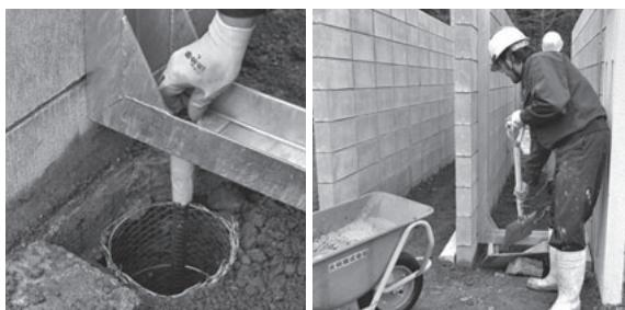
5. ロックボルトのセットとコンクリート流し込み
