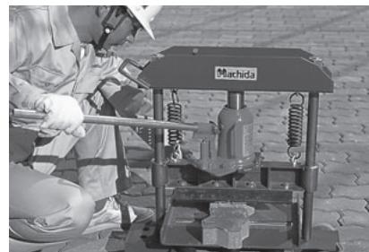
端部で端部用ブロックでは処理できない箇所は、寸法に合わせ、スプリットカッターでカットし、敷き込みます。
