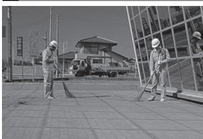
乾燥した細目の砂をホウキなどで目地に落とし込み、作業は完了です。
