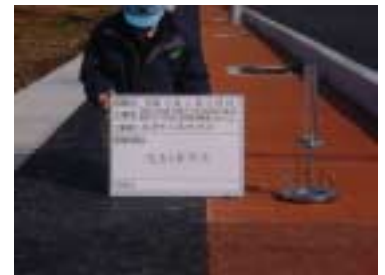
浸透水量試験状況
