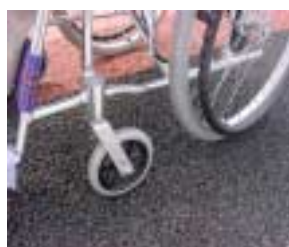
透水性アスファルト舗装
